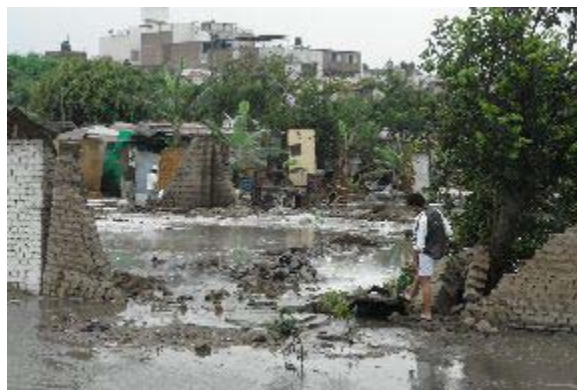
Figura 7. Casas rústicas construidas al margen del Río Moche inundadas
